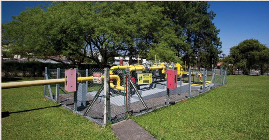
Estação de medição e redução de pressão do gás natural instalada pela Compagas no cliente industrial. Crédito: Divulgação Compagas.
